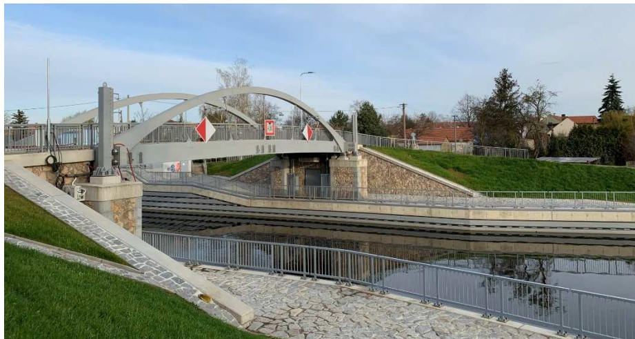
Obr. 2 – Nová zdvižný most ve Vraňanech
