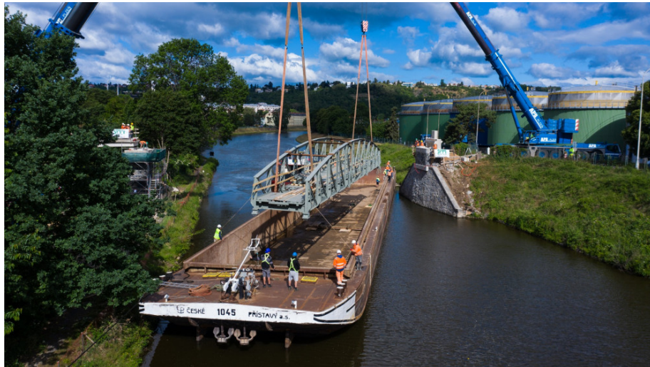
Obr. 3 – Instalace nové mostovky bývalé polní dráhy
